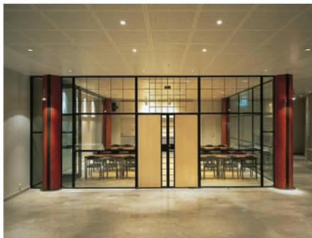
Si une protection permanente conforme à la norme NBN B 02-004 (en préparation) était prévue, le verre intérieur feuilleté (côté du choc) pourrait être remplacé par un verre float si la protection permanente était placée à l'intérieur (côté du choc) ou un verre trempé si elle était prévue à l'extérieur (côté opposé au choc).
