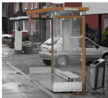
Le tableau 6 distingue deux cas selon que la base du vitrage se situe à moins ou à partir de 0,9 m du niveau du sol. Ces autres applications mettent généralement en œuvre des verres simples. Pour les deux exemples présentées dans la figure 12 (p. 10), la base du vitrage étant à moins de 0,9 m du niveau du sol, un verre 1B1, autrement dit un verre feuilleté composé de deux feuilles de verre et de deux PVB (minimum 33.2), ou 1C1, c.-à-d. un verre trempé (minimum 4 mm), est préconisé.
